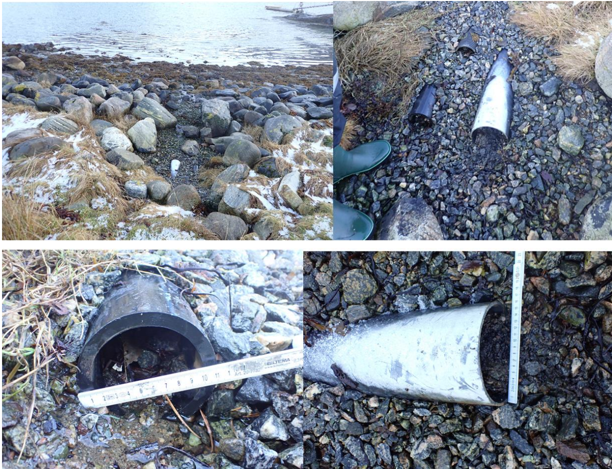
Figur 13: Observasjon av utløp for eksisterende VA-ledninger nede ved fjorden.
